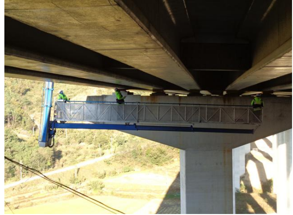
굴절점검차를 이용한 근접조사
