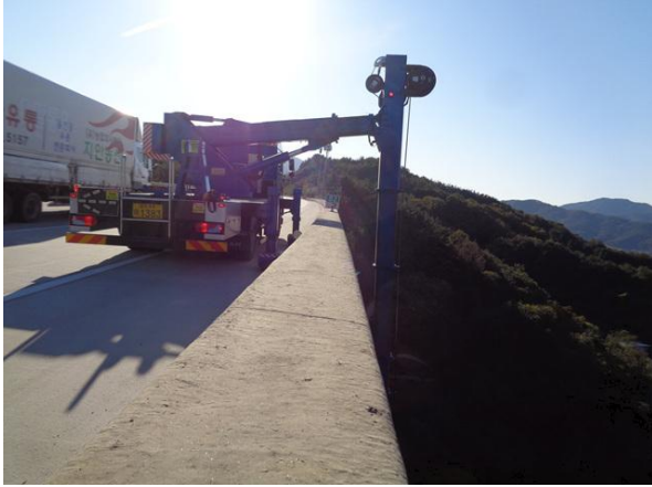
굴절점검차를 이용한 근접조사
