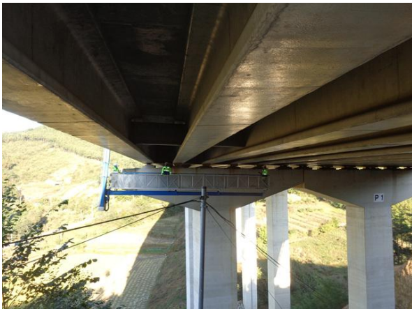
굴절점검차를 이용한 근접조사
